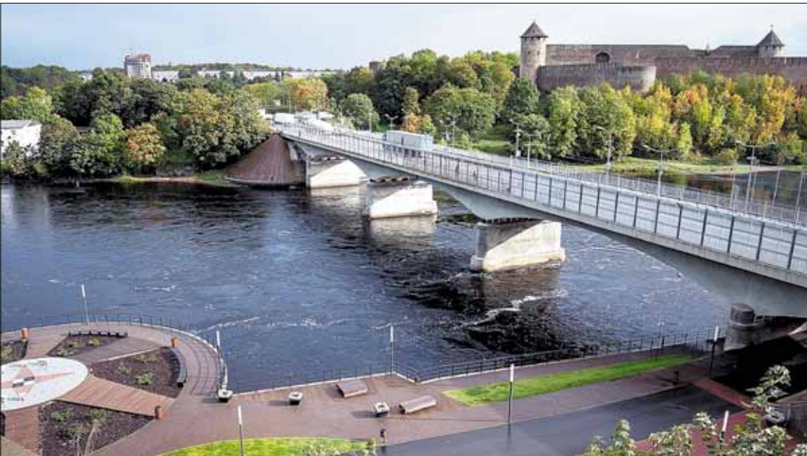
После отхода Красной Армии 17 августа 1941 года гранитный мост, действовавший здесь с 1829 года, был взорван боевыми водолазами РОН. Благодаря этому наступление группировки Вермахта было сорвано
